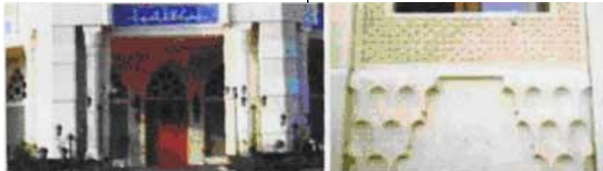
صورة (١١) استخدام المقرنصات والأعمدة بواجهة مبنى المشيخة
